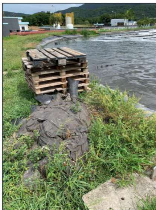
Foto 04: Fragmentos de geomembrana e manta geotêxtil não-tecido (Bidim) retiradas da lagoa (25/01/2022).
