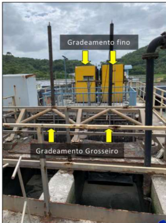
Foto 01: Gradeamento grosso (1º plano) e gradeamento fino (2º plano) – 25/01/2022.
