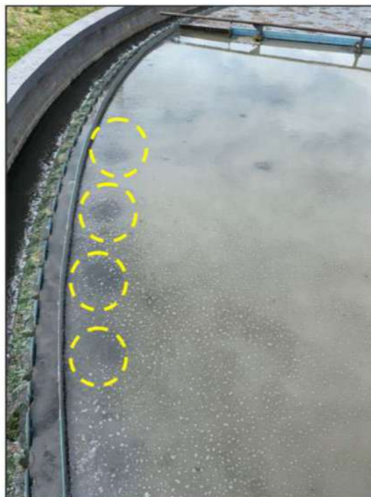
Foto 12: Maiores bolhas de biogás sendo liberadas e permitindo o afloramento de lodo (25/01/2022).
