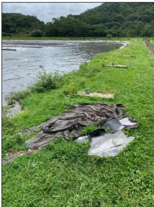
Foto 05: Fragmentos de geomembrana e manta geotêxtil não-tecido (Bidim) retiradas da lagoa (25/01/2022).
