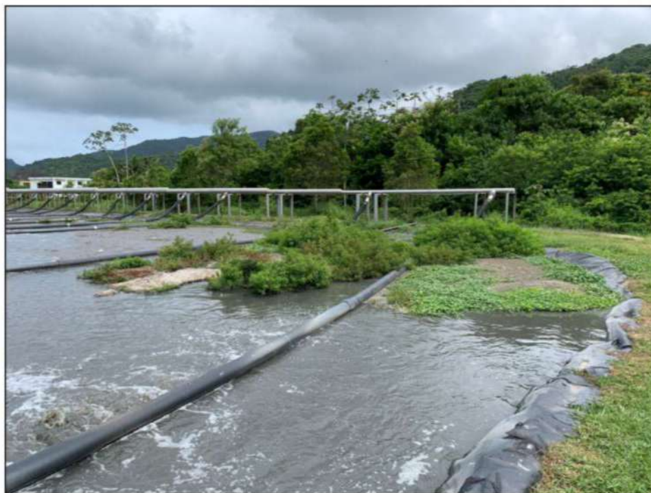
Foto 10: "Ilhas de resíduos" com vegetação no tanque aerado (25/02/2022).
