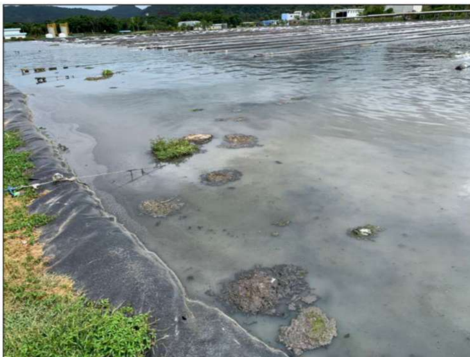
Foto 08: Zonas mortas no tanque aerado com coloração acinzentada e lodo flotando (25/01/2022).
