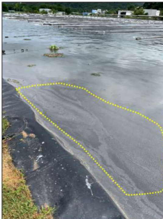
Foto 07: Zonas com decomposição anaeróbia e liberação de gases (pequenas bolhas na superfície - linha pontilhada) – 25/02/2021.
