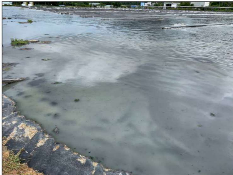
Foto 09: Zonas mortas no tanque aerado com coloração acinzentada (25/01/2022).
